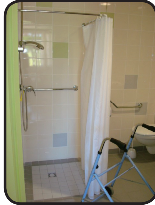
Rénovation d'une salle de bain
